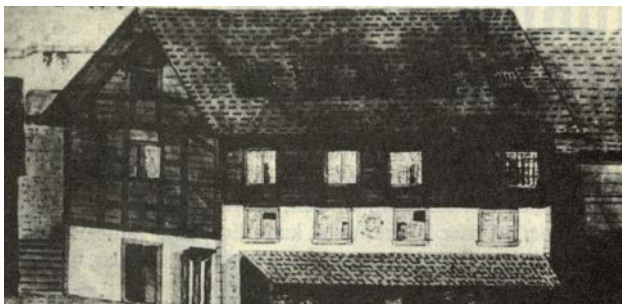
Niederer Spital am Rathausplatz Thun: Das Pfründerhaus wurde 1348 erbaut.
